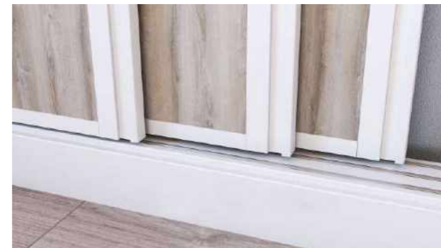
Detalle frente corredera 3 carriles Perfil SUN
